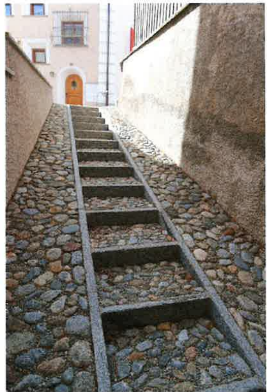
Zugang zum Gebäude
