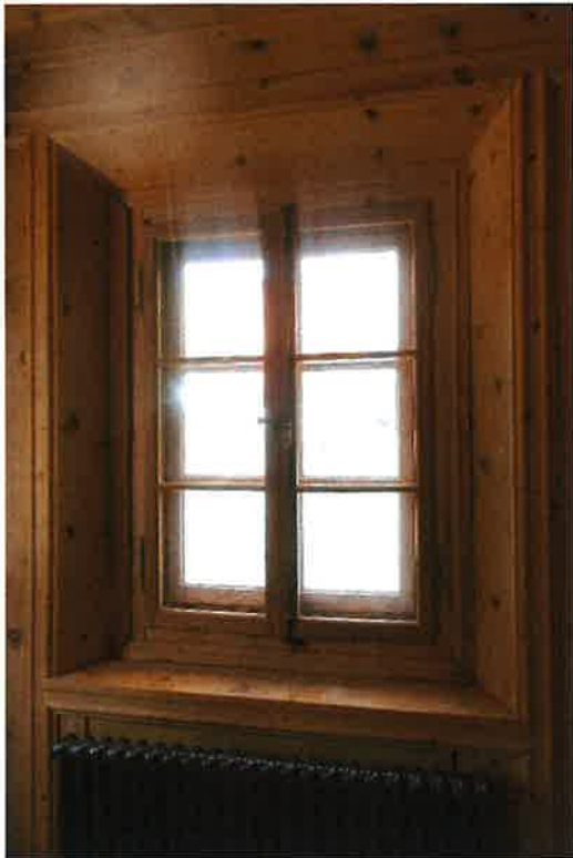
Fenster mit Vorfenster
