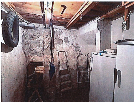
Keller (Feuchtigkeitsinfiltration)
