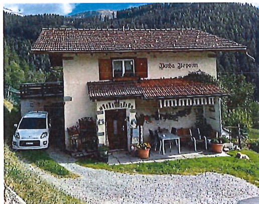
Zufahrt und Terrasse im Westen
